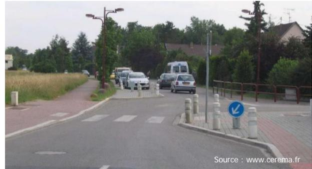
Décrochement vertical de type plateau surélevé (à gauche) et décrochement vertical de type écluse (à droite)
